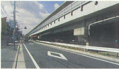
施工前の北村高架橋
