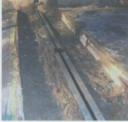
ショーボンドクローザーの設置状況
