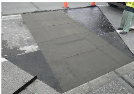
7. ひび割れ抑制シートの貼り付け
