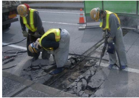
1. 既設伸縮装置の撤去
