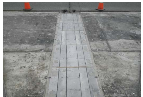
6. 連続化装置の設置完了
