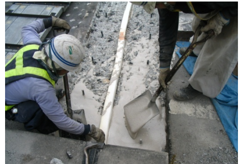
4. 樹脂モルタル(JH-3モルタル)の打設
