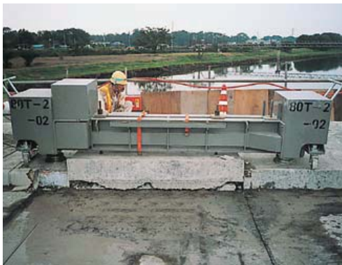
②既設床版の解体・撤去
