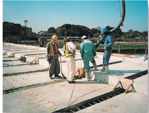
④継手部の配筋・打設
