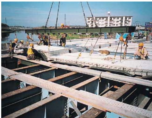
③スーパー床版の架設
