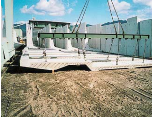
①スーパー床版製作
