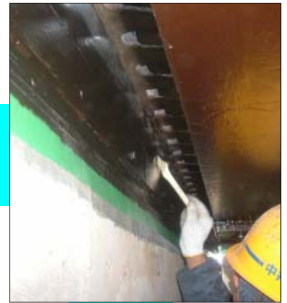
プライマー塗布
