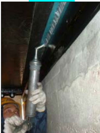
下面・地覆端部コーキング処理
